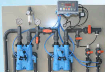
Instalação Ultrapur Painel para regeneração desmineralizadores
