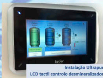
Instalação Ultrapur Painel para regeneração desmineralizadores
